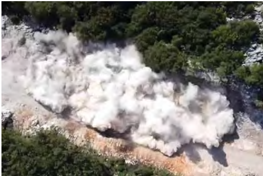
■ Miniranje Poliexovim proizvodima na izgradnji puta Cetinje - Čevo
