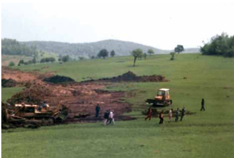
■ Početak radova na izgradnji fabrike
