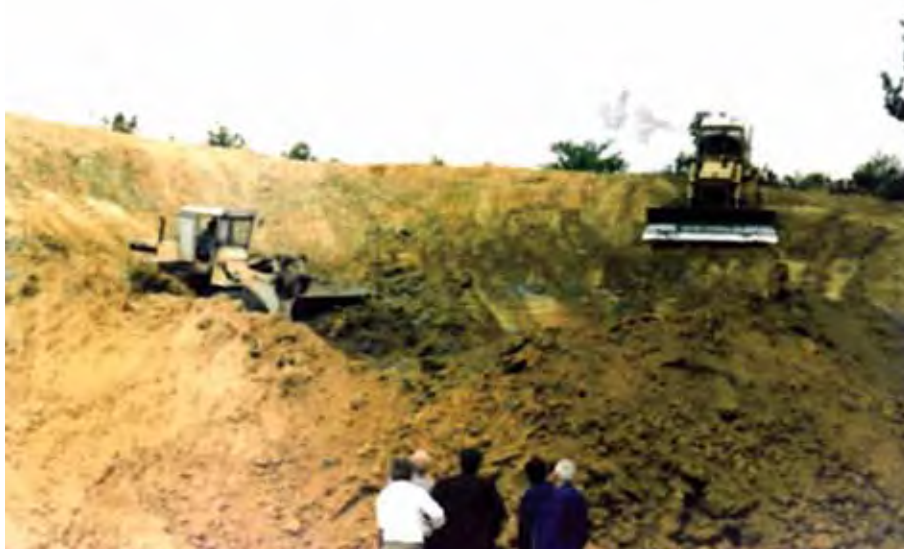
■ Temelji objekata P 01 i P 02
